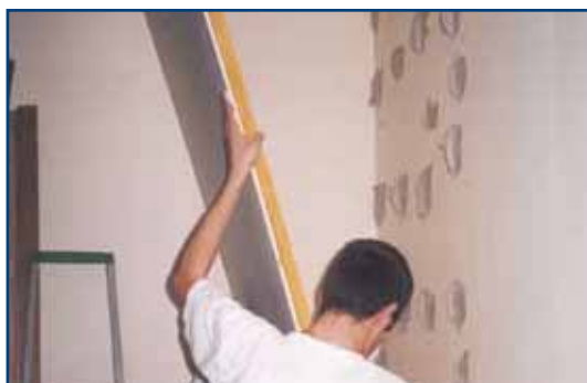
3. Posizionamento della lastra di SILENTGips
