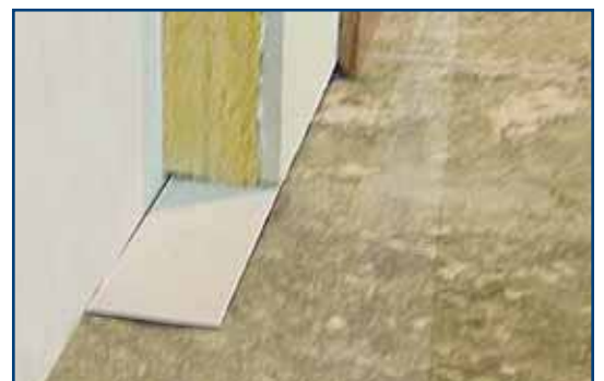
2. Posizionamento della fascia di guarnizione
