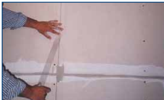
5. Posa e sigillatura del cartongesso
