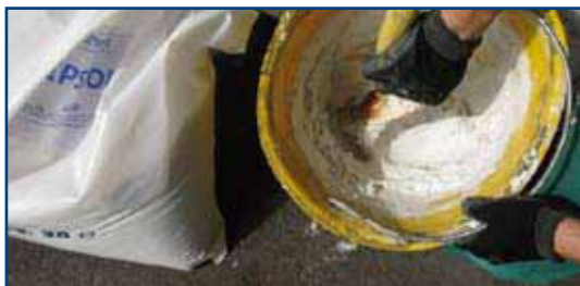
1. Si mescola l'adesivo in polvere GIPSCOLL con acqua.
