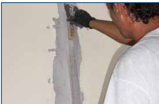
5. Sigillatura tra i pannelli di TOPSILENTDuogips
