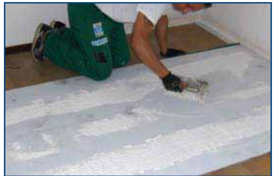
2. Stesura della colla GIPSCOLL sul pannello
