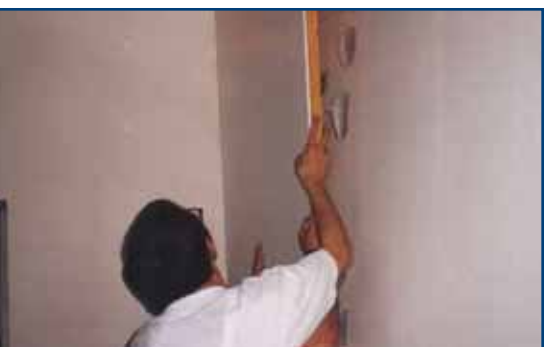
2. Posizionamento della fascia di guarnizione
