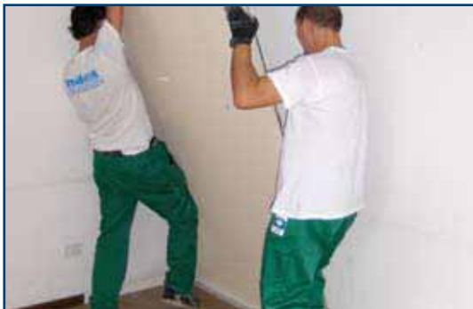
3. Posizionamento del pannello di TOPSILENTDuogips
