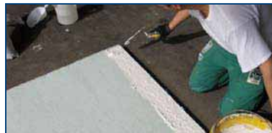
2. Si stende con la spatola sulla lana di TOPSILENTEco.
