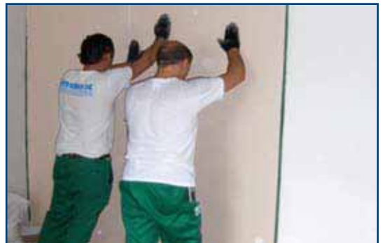
4. Posizionamento di un altro pannello di TOPSILENTDuogips
