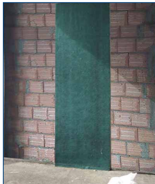
6. La posa è terminata.
