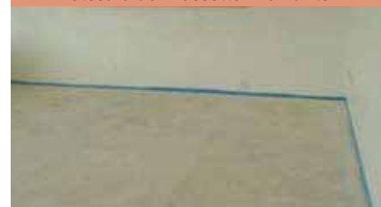
Stesura del massetto in anidrite
