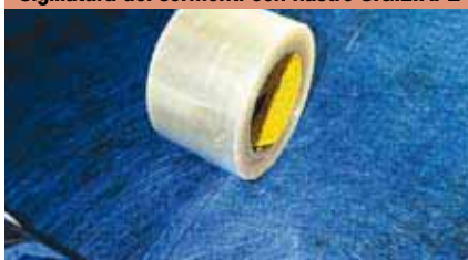
Sigillatura dei sormonti con nastro SIGILTAPE
