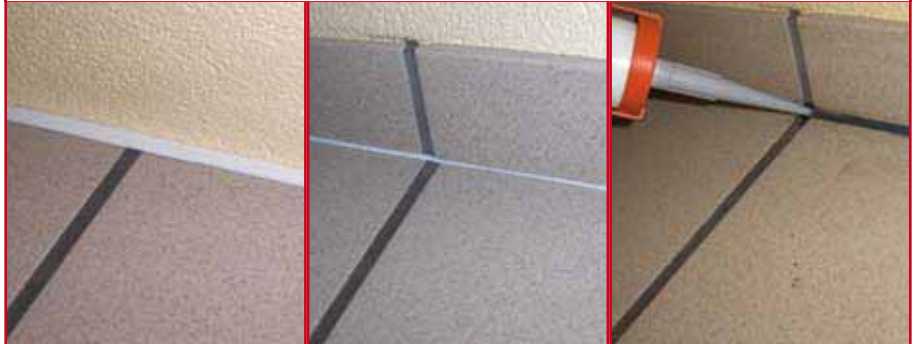
BANDELLA ADESIVA DISTANZIATRICE E SIGILLATURA ELASTICA
