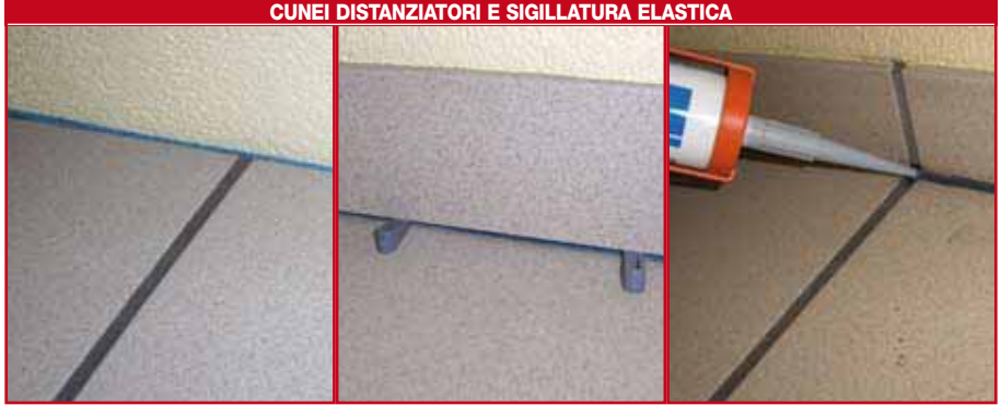
BANDELLA ADESIVA DISTANZIATRICE E SIGILLATURA ELASTICA
